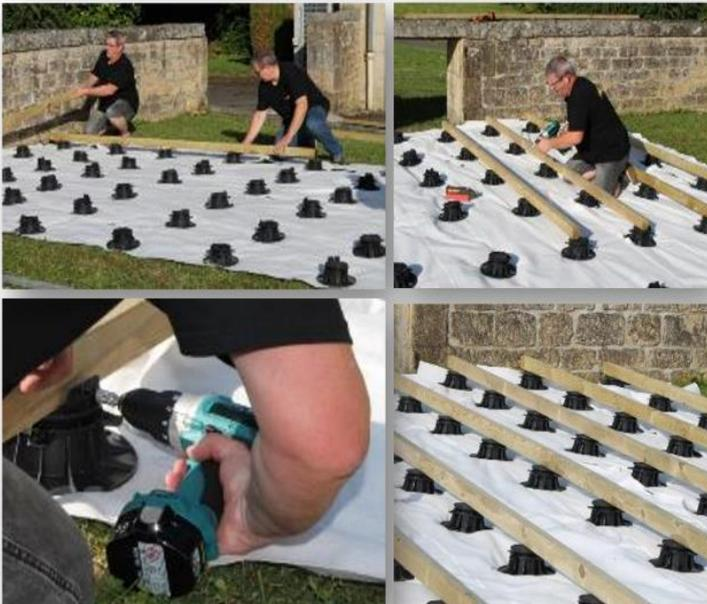
> Verlegen Sie die Stützbalken auf die Reihen der Blöcke und befestigen Sie diese mit den ROCKET-Edelstahl-Schrauben 5x40.
